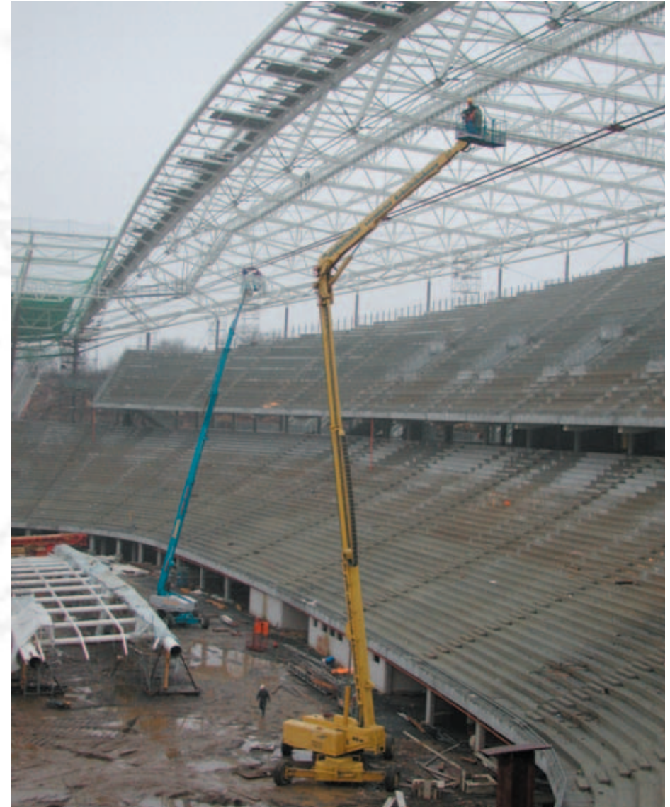
Bild 5-1: Hubarbeitsbühne im Baustelleneinsatz
